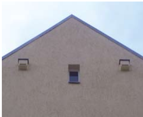
Budky pro netopýři, instalované na zateplenou stěnu
