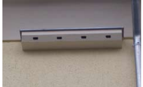
Čtyřkomorová hnízdní budka, umístěná přímo na stěně budovy
