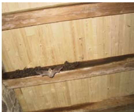
Příklad správně provedené rekonstrukce – opravený strop s kolonií netopýra velkého na hradišti Týnci nad Sázavou
