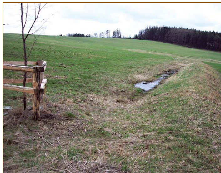
Obr. 4-18: Průleh (Milínov, foto VÚMOP, v.v.i.). Tento průleh nesplňuje díky hrázce s příliš strmými svahy základní podmínku průlehu – tedy možnost přejíždět mechanizací. Stejně tak by bylo možno ho nazvat mezí se zachytňným nebo svodným prvkem nebo zemní hrázkou s příkopem. Val by mohl být osázen vegetací.
