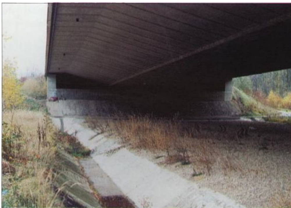
Foto 9 – Průchodnost omezuje také šterkové zpevnění podmostí (D11)
