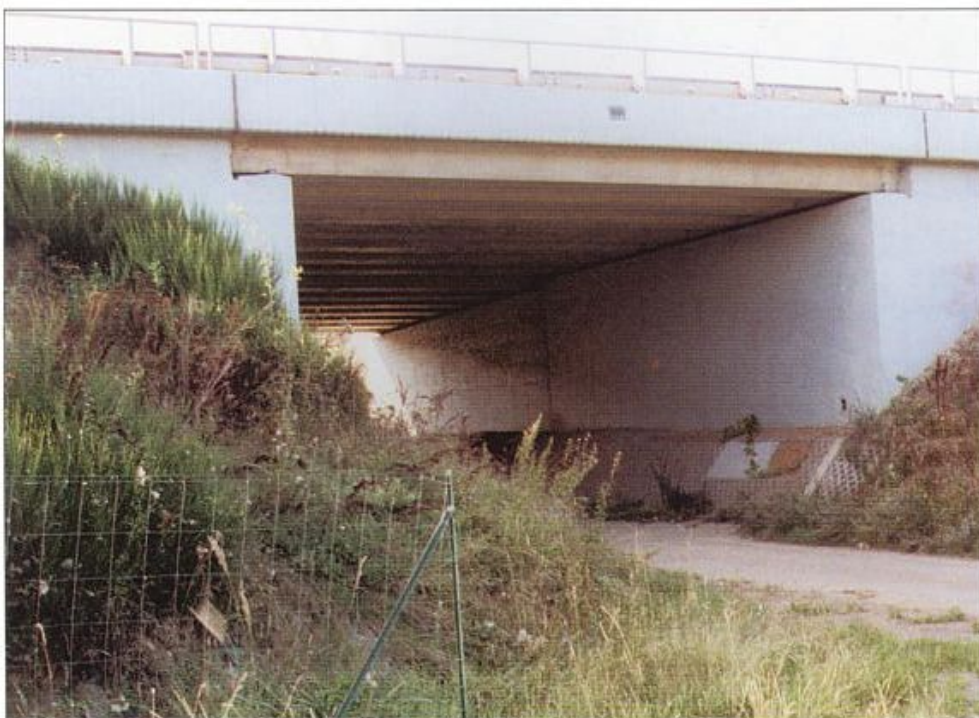
Foto 12 – Podstatný vliv na funkčnost oplocení má také napojení oplocení na mostní konstrukce. Při nedokonalém napojení se zvěř v těchto místech rovněž snadno dostává do prostoru mezi plot a dálnici (D5)
