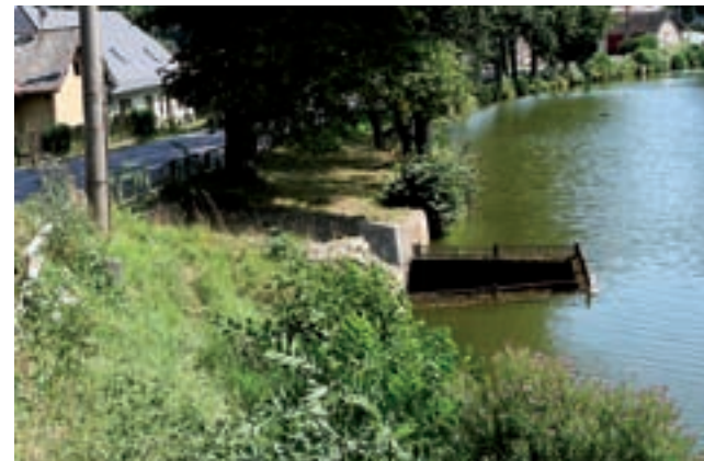
Obr. 15: Kašnový bezpečnostní přeliv
