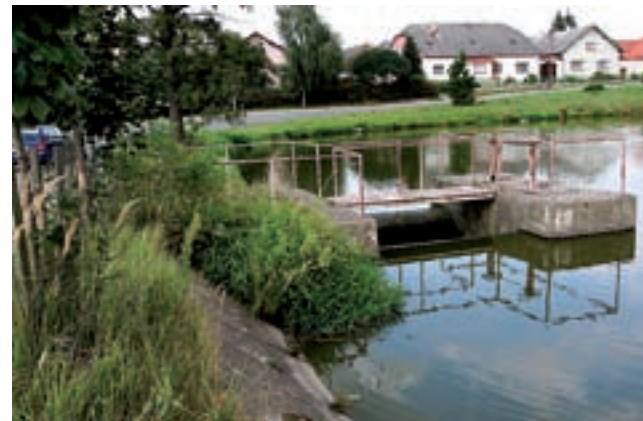
Obr. 14: Sdužený bezpečnostní objekt
