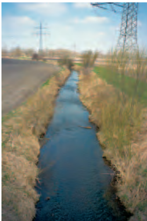
Před revitalizací: Napříměný kanál bez mrtvého dřeva.
