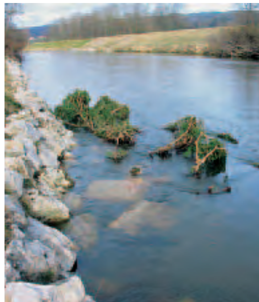
Kombinované struktury z kamenů a stromových kmenů nabízejí stanoviště a ochranu jak rybímu dorostu, tak i velkým rybám.
