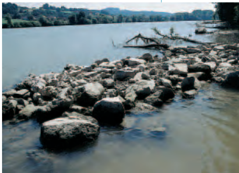
Nový kamenný výhon se zabudovanými strukturami z mrtvého dřeva.
