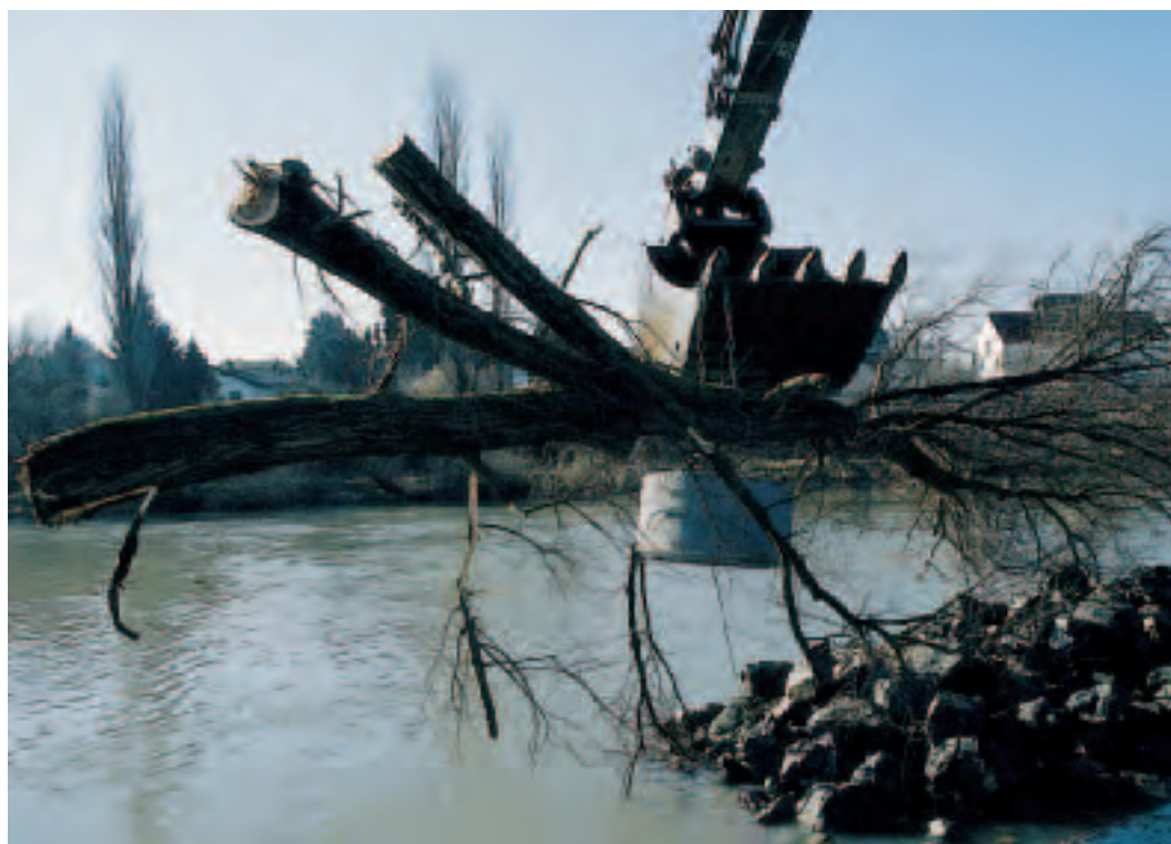
Vkládání mrtvého dřeva, zajištěného betonovými bloky a ocelovými řetězy, do paralelní říční hrázky.
