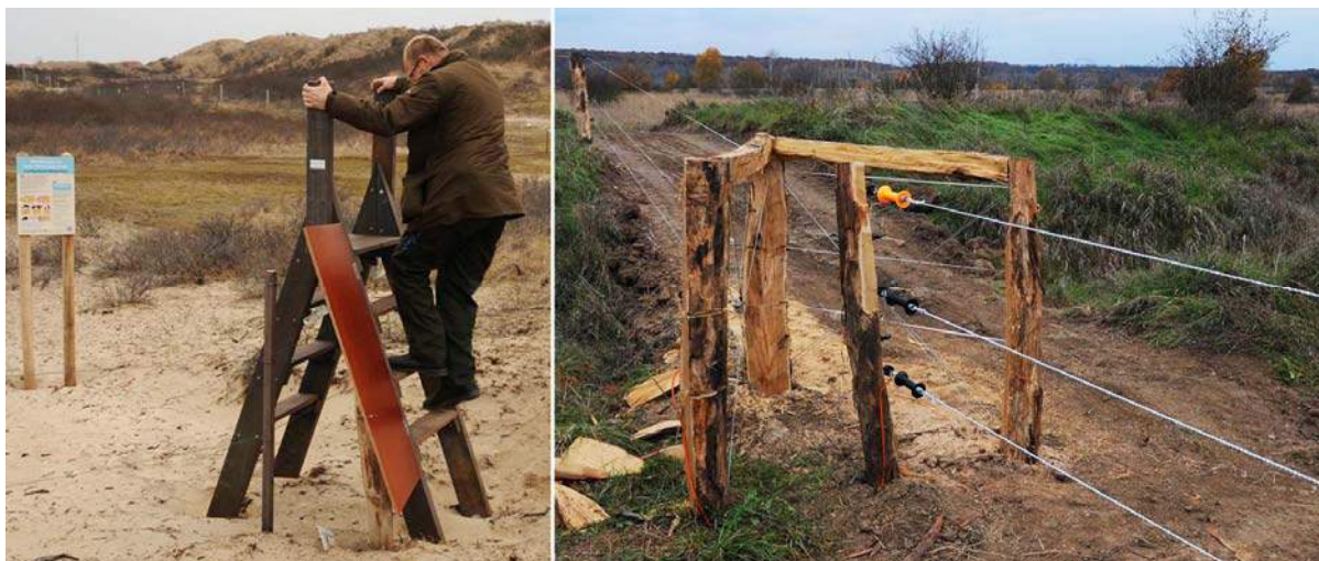
Obr. 28. Vlevo: Schůdky pro přelézání elektrického ohradníku – schůdky lze uzavřít dvířky a dát tak návštěvníkům najevo, že rezervace je uzavřena; přelezy jsou ideálním místem pro umístění informačních tabulí. Jak je vidět na obrázku vlevo, rezervace udržované pastvou zubrů a koní stačí obehnat lehkým, téměř neviditelným ohradníkem – zubři, nejsou-li rušeni a lidé chodí jen po značených stezkách, jej bez problému respektují (na 220 ha písčinych dun na okraji aglomerace Haarlemu zde žije 24 zubrů a kolem 10 koní). Kraansvlak, NP Zuid-Kennemerland, Holandsko. Vpravo: Průchod pro pěší – půdorys písmene V umožňuje projít pouze lidem; elastická vodivá lanka v pravé části snímku slouží jako branka – praktičtější jsou však kovové pružiny, které mají dlouhou životnost a nelze je snadno odcizit. Milovice. © M. Jirků
