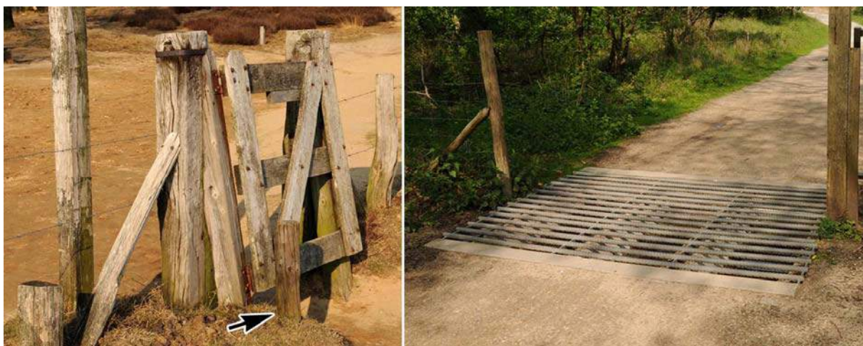
Obr. 29. Branka pro pěší (vlevo) – naklonění ven z pastviny zaručuje samovolné zavírání, kolík označený šipkou zabraňuje přílišnému otevření dvířek a jejich převážení do polohy otevřeno. NP Veluwe, Holandsko. Takzvané texaské brány jsou rošty položené přes komunikace procházející ohradou – umožňují průjezd vozidel, omezují však pohyb kopytníků a nenahrazují tedy průchody pro zvěř. NP Zuid-Kennemerland, Holandsko. © M. Jirků
