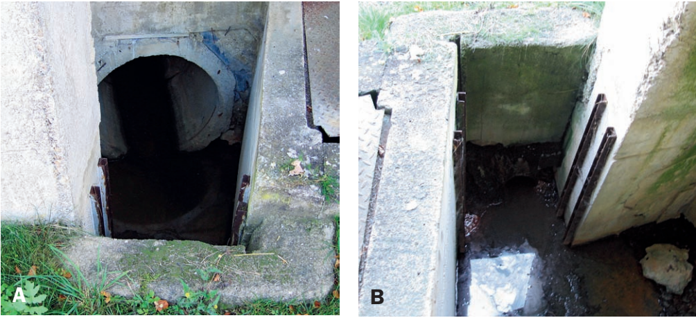
29. Detail vyústění vody z rybníka v Mláce.
