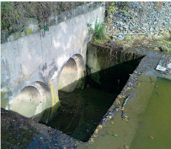
33. Detail neprůchozího přelivu rybníka Rozňák.
