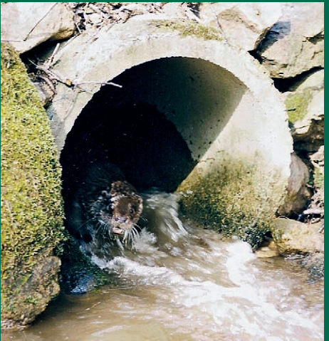
2. Vhodné řešení. Propustky, kde množství protékající vody umožňuje vydře jít po dně, jsou pro ni většinou průchodné.
