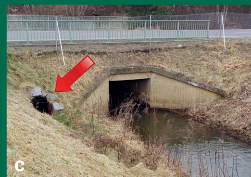
3. Úpravy nevhodných řešení. Původně neprůchozí most lze upravit např. dodatečným vybudováním berm (obr. A) nebo lávky (obr. B), nejlépe po obou stranách. Pokud není možné jejich vybudování (nepřípustné snížení kapacity mostu, příliš složité či nákladné řešení), je možné most zprůchodnit vybudováním vydrího tunelu (obr. C).
