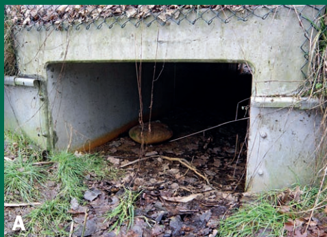
4. Vhodné řešení. Propustky s přirozeným dnem (obr. A) využívají vydry ochotněji než v případě technického dna (obr. B). Přirozené dno také umožňuje snadnější monitoring funkčnosti (viditelné stopy, v tomto případě navíc vhodně umístěný kámen vybízí vydra ke značkování).
